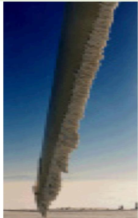
*La formation de glace réduit l'efficacité d'une éolienne. On doit chauffer les pales en hiver avec du courant électrique. Photo: Eolienne 150 kW sur Obergrenchenberg SO, 1'300 m.s.m. ©Timo Laakso 2009*
